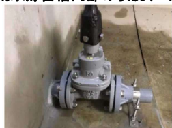
雨水貯留槽内部の状況(バルブ)
