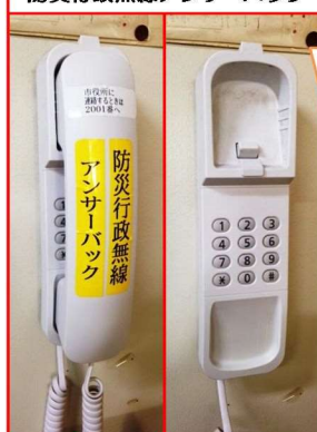
防災行政無線アンサーバック
